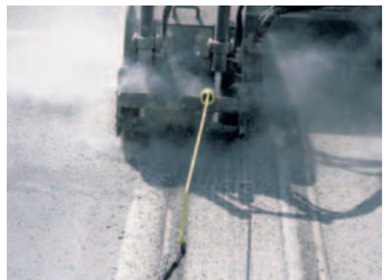
Une tige de guidage est disponible en option pour les raboteuses Bobcat 14", 16", 18" et 24"; elle aide l'opérateur à réaliser une coupe parfaitement rectiligne.
